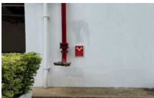
หัวรับน้ำดับเพลิงอาคาร A และ B และท่อเย็น
